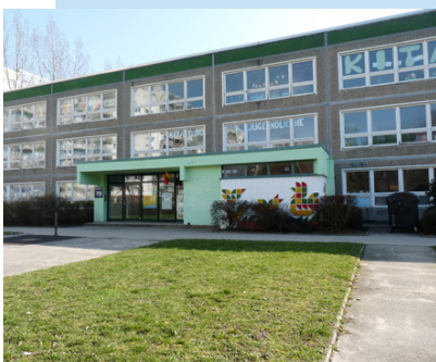
Kita Akazieninsel vor der Sanierung
