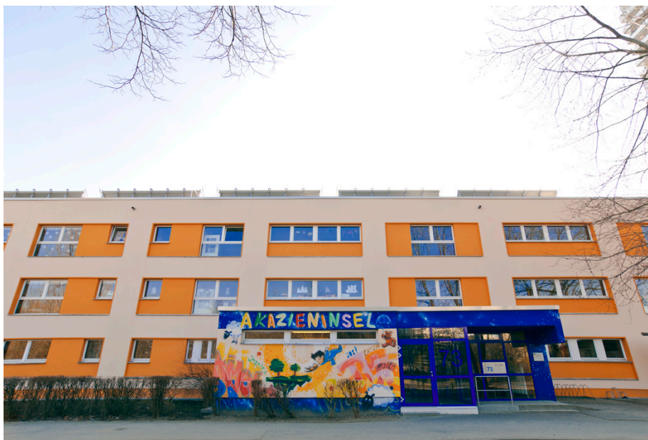
Schmuckstück mit Solaranlage nach der Sanierung
